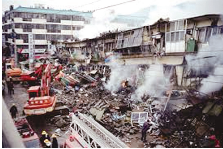
[사진 1] 청주우암상가아파트 붕괴사고
