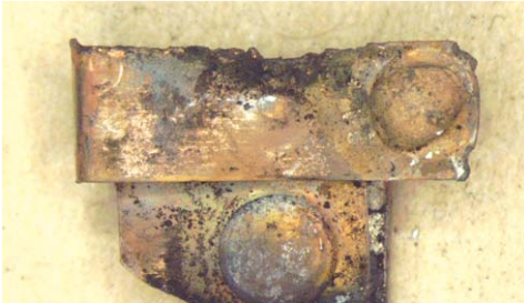
[그림 17] 바이메탈 서모스탯 접점의 연소상황 (수열되고 용융된 상태)
