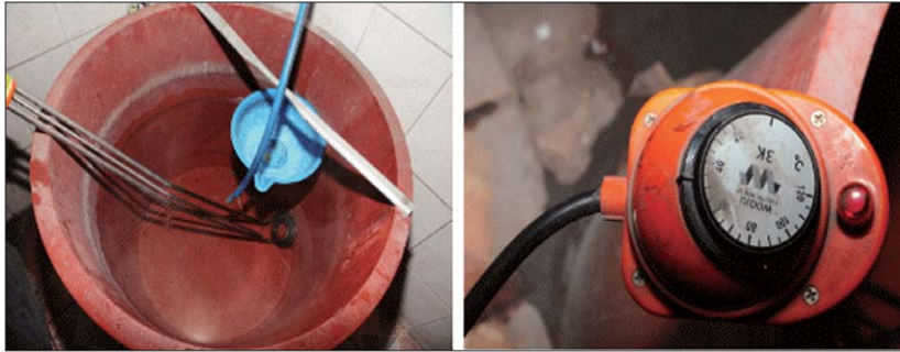
[그림 2] 사례의 시즈히터의 자동온도조절장치는 45°C에 설정되어 있다.
