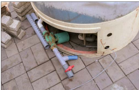
[그림 8] 드레인밸브 잠김 상태
