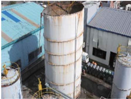
[그림 3] 원통형 유류 저장 탱크의 폭발, 상부경판은 300m 비행 후 인근 들판에 착지
