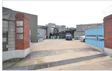
[사진 1] 화재건물 외부의 연소상황
