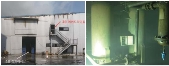
[사진 6] A동 컴프레서실 전경 [사진 7] 2층 에어 드라이실 내부 모습
