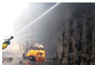
[사진 4] 지게차를 이용한 가연물 제거 작업
