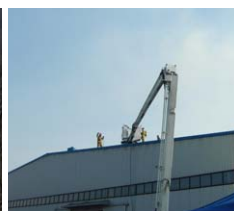
[사진 5] 굴절차 지붕 천공작업
