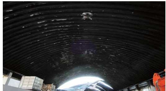
[사진 8] 전소된 지붕 마감재(발포우레탄)
