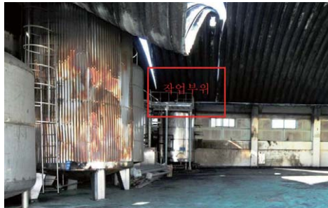
[사진 9] 가스절단 작업부위 및 주위부분
