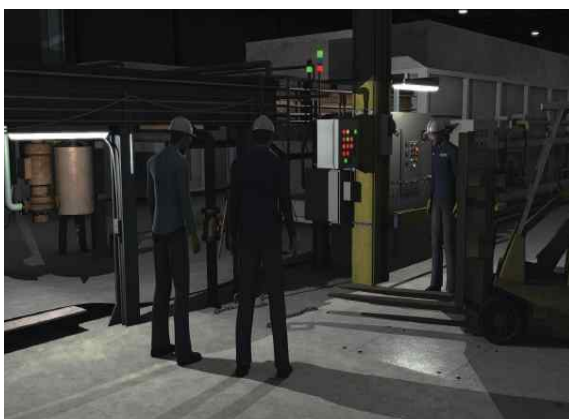
[그림 10] 5월 27일 폭발 전 지게차를 이용하여 도랑덮개를 들어올리려는 보수기술자 [컴퓨터 그래픽]
