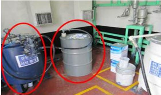
배합실 내부에 설치된 드럼(페인트 용기), 교반탱크 및 이송펌프에 접지 미설치
