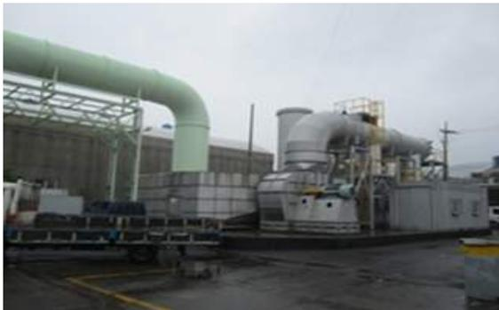
환기설비용 RTO(Regenerative Thermal Oxidizer)에 상용전원 차단에 대비한 비상전원설비가 설치되지 않음.
