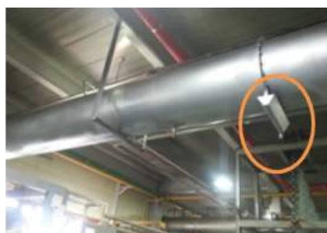
<물받이 설치 모습>
