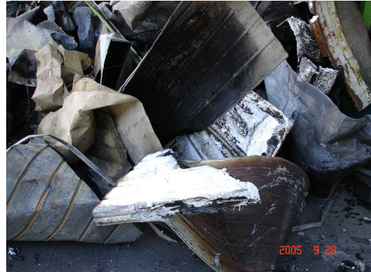
[사진 2] 스티로폼을 사용한 패널 : 보온재로 사용한 스티로폼으로 인하여 유독성 가스가 많이 발생하였다.
