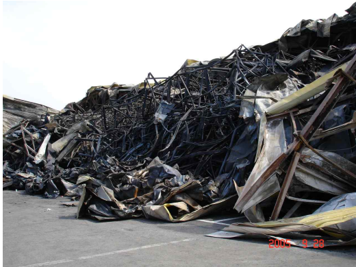
[사진 1] 창고 반대편 작업장 : 철골구조가 완전히 붕괴되었다.
