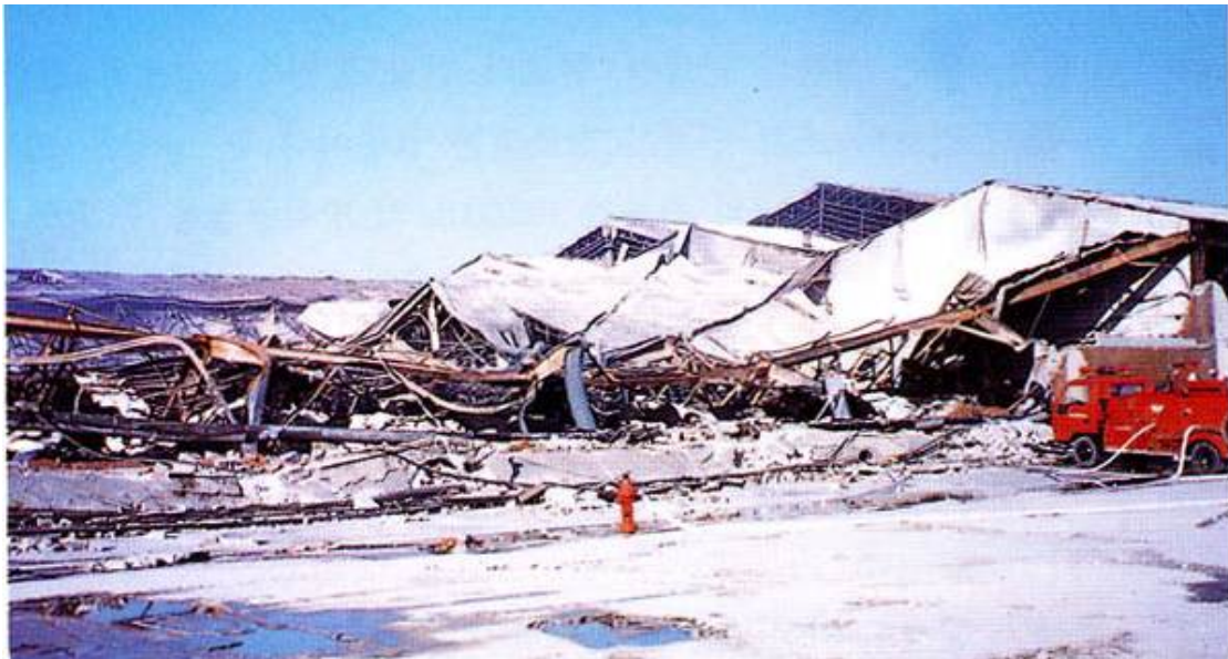
[사진 3] 건물 남서쪽 Grey room- 내부는 물론 외벽이 붕괴되었다.
