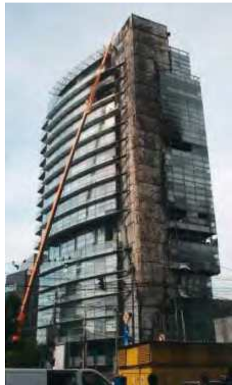
디자인적인 이유로, 고층건물의 외벽은 유리나 알루미늄 패널로 시공
