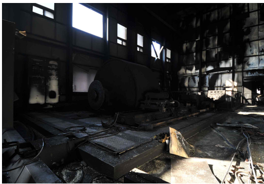
[사진 5] 용접 작업장소 주위 환경
