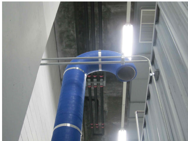
[그림 7] 흡기구(급기구)의 설치 모습
