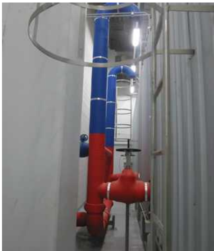
[그림 6] 사수방지설비의 설치 모습
