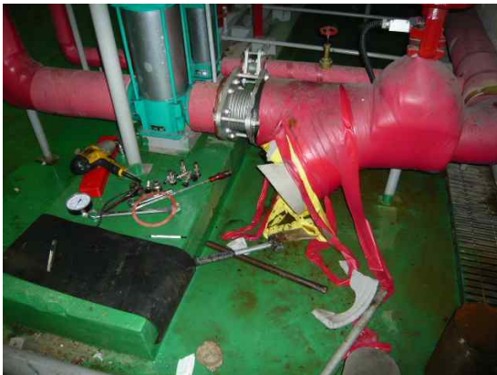
[사진 1] Y형스트레이너의 분리 점검
