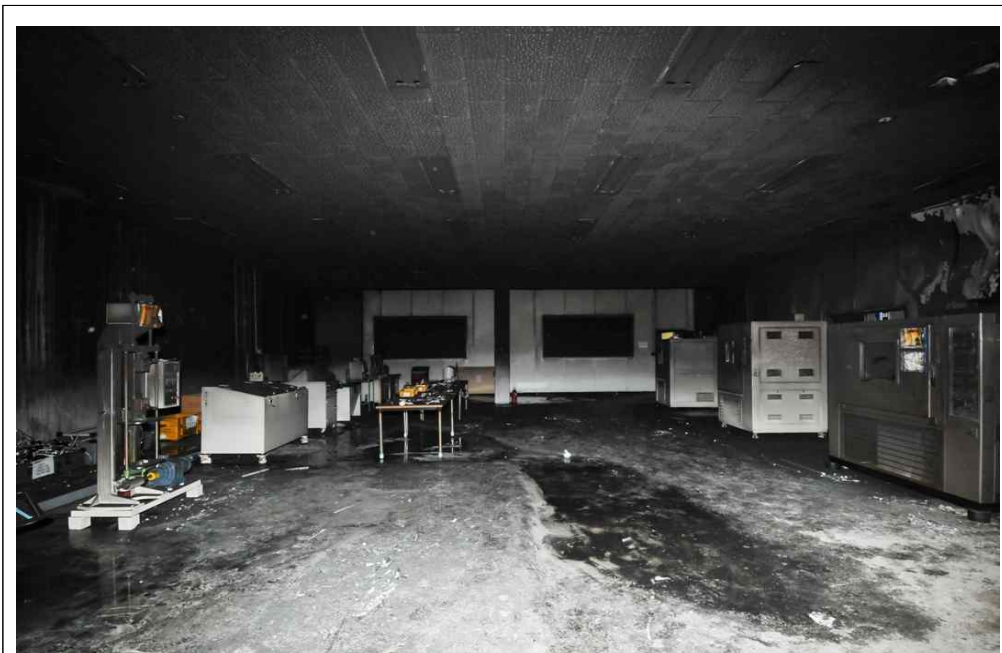
[사진 2] 1층 시험실의 연소상황(우측 방향의 상황)
