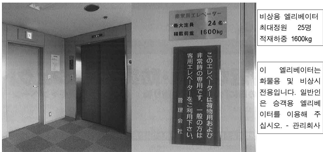
[그림 4] (좌)비상용 엘리베이터와 특별피난계단, (우) 비상용 엘리베이터의 주의문구
