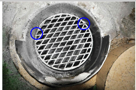
[사진4] 사진3호의 □표지부분, 재용당 배관 투입구의 상황(○표지부분은 용접한 부분)
