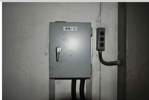
[사진5] 용접작업 시 사용한 용접기반 외함의 상황(사이로 ①호기 5층 재용당 작업장 내에 설치)
