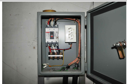
[사진6] 용접기반 내부 차단기 및 콘센트의 상황
