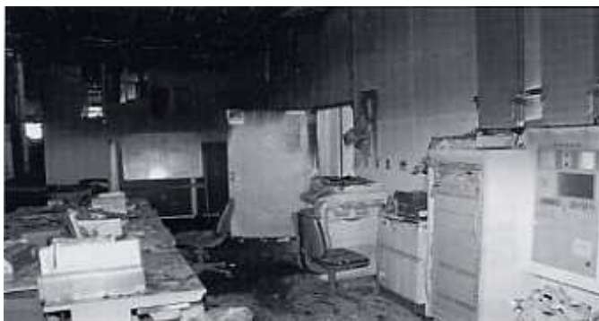
[사진 6] 1층 동쪽 사무실
