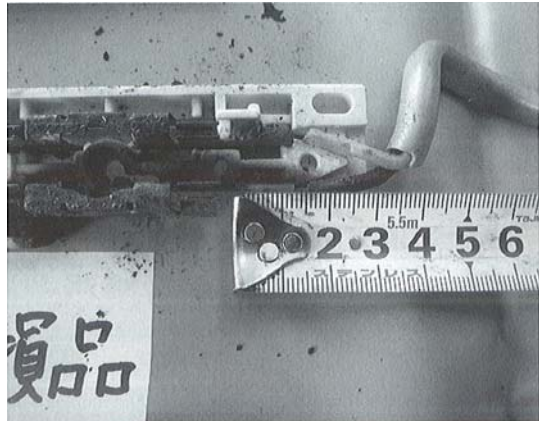
[사진 9] 배선(단선) 연결 상황
