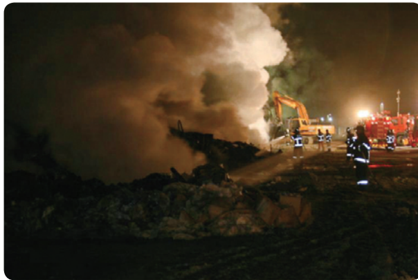
사진 3. 물류창고 뒤편 콘크리트 바닥 천공 후 배연 및 방수작업 실시
