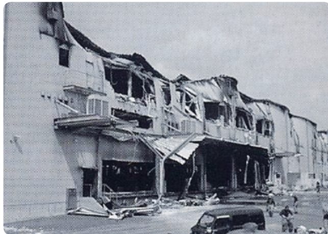
사진 2. 창고 3층 연소 상황창고 겸 작업장 남측 외관(일부가 중기로 파괴)
