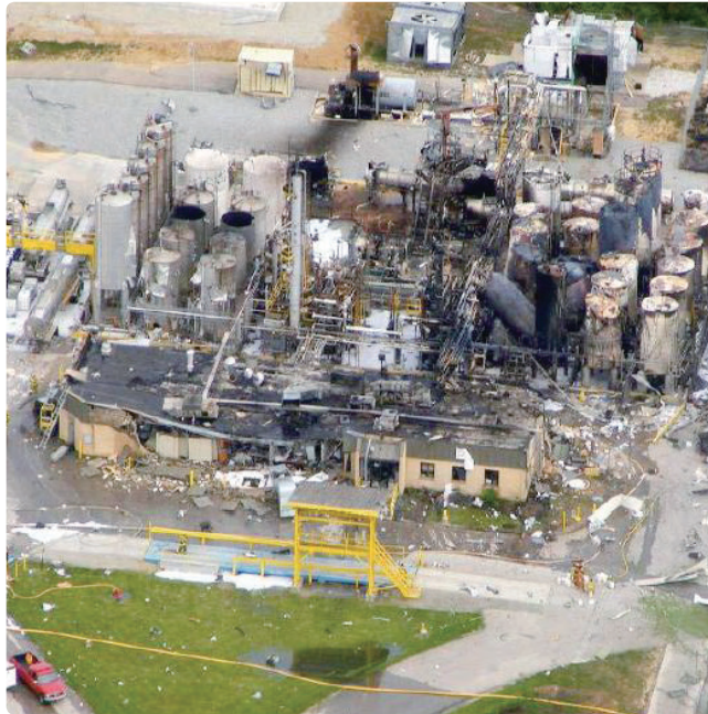
사진 1. 베올리아 공장의 폭발사고 후 사진
