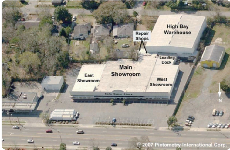
사진 2. 소파 판매점의 건물 항공사진
