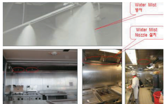
【그림 10】 고압식 Water Mist System을 이용한 주방소화설비
