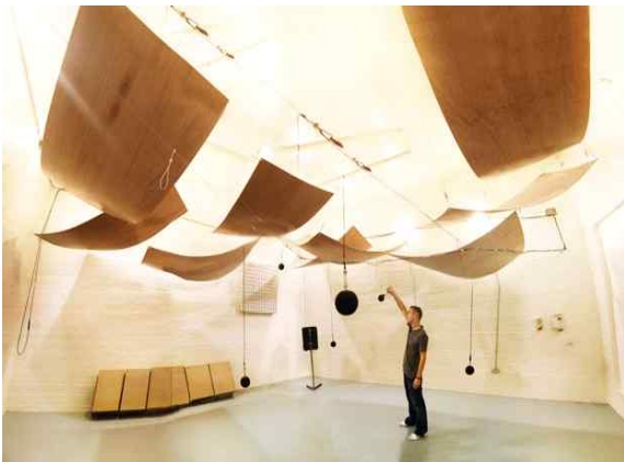
[그림 8] 확산판의 설치 예
