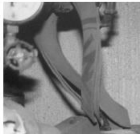
[그림 5-2] 시건장치가 설치된 OS&Y 밸브
